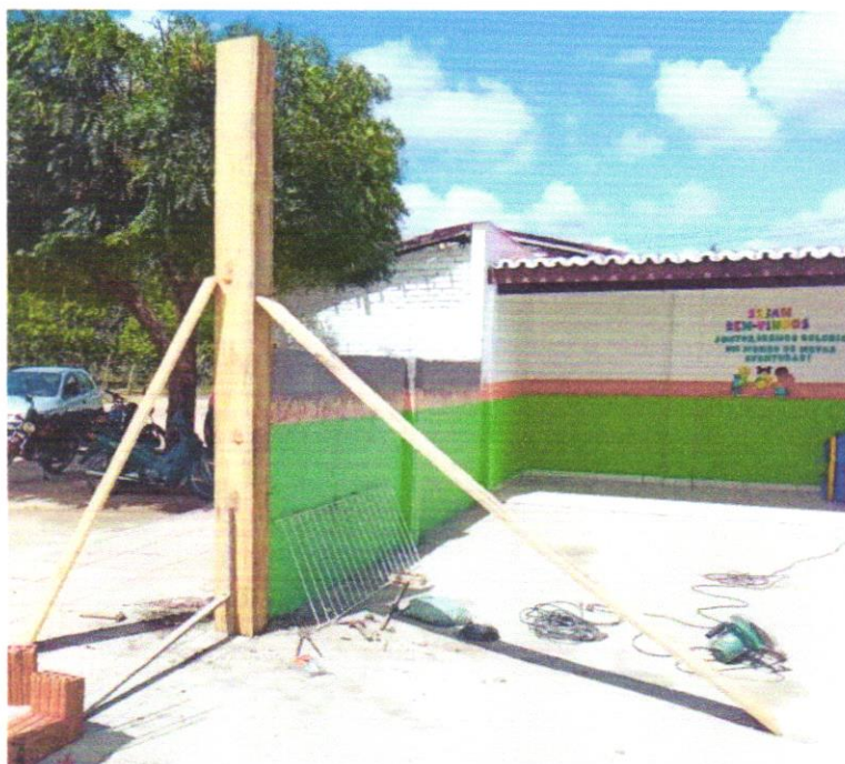
FOTO 05 - FABRICAÇÃO DE FÔRMA PARA PILARES E ESTRUTURAS SIMILARES, EM CHAPA DE MADEIRA COMPENSADA PLASTIFICADA, E = 18 MM. AF_09/2020
